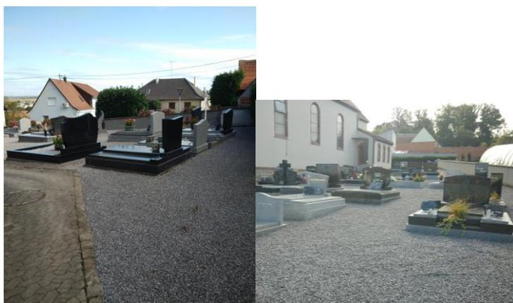
Les travaux concernant la mise en place d'un système de stabilisation des allées du cimetière sont terminés. La mise en œuvre a consisté à mettre en place une structure alvéolaire (nid d'abeille) sur un terrain préparé ; cette structure vise à stabiliser le revêtement gravier et à empêcher les ravinements connus jusqu'à présent en cas de pluies importantes.
