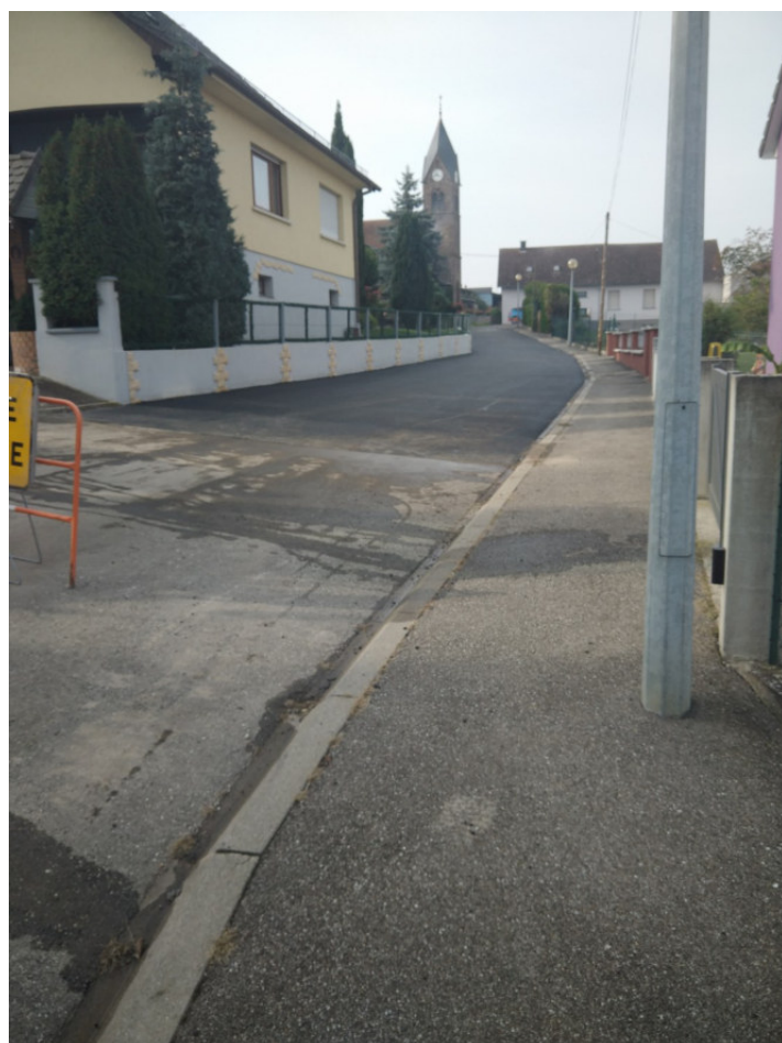
Rue des jardins (après travaux)
