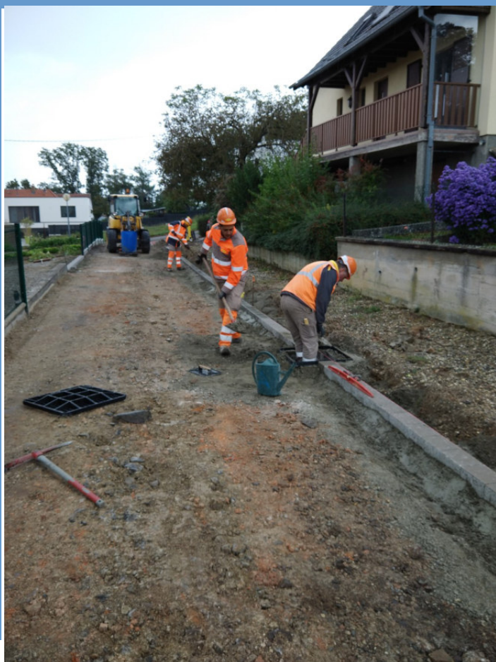
Haut de la rue de l'église (pendant les travaux)
