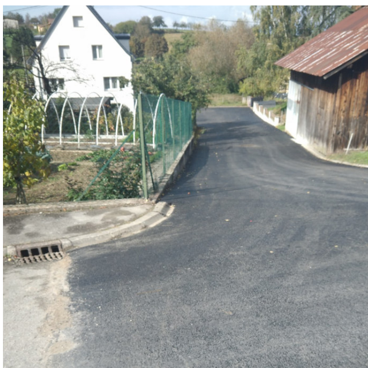
Embranchement rue de la carrière—rue de la prairie (après les travaux)
