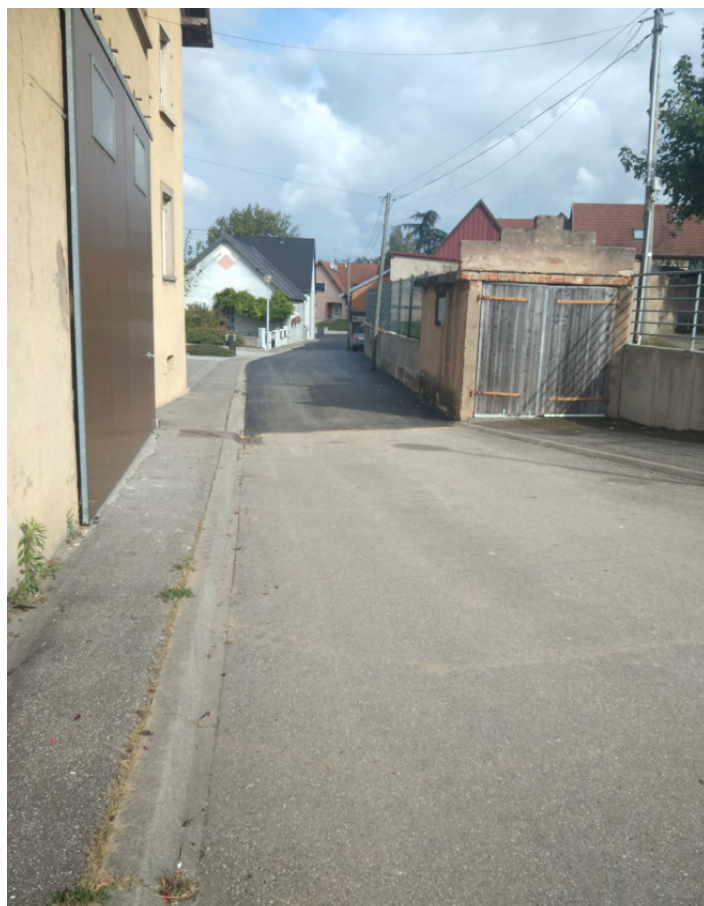
Rue de la prairie (après les travaux)
