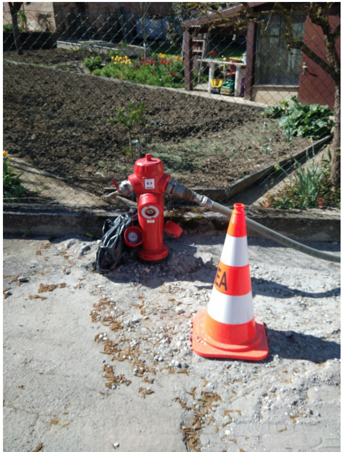
Remplacement d'une ancienne bouche d'incendie rue du houblon
