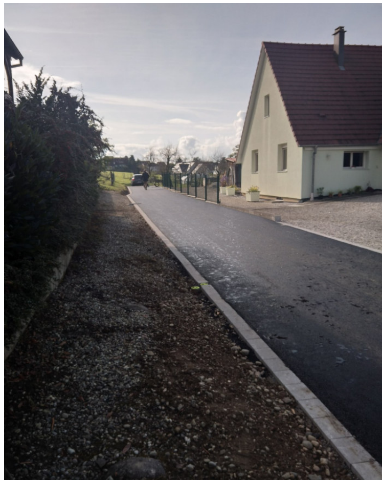
Haut de la rue de l'église (après les travaux)
