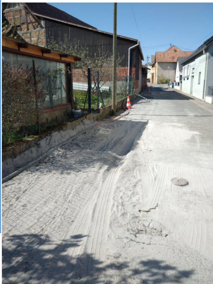
Rue de la prairie (pendant les travaux)
