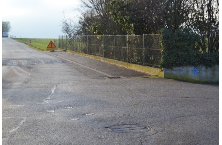
Trottoir RD70 (tronçon resté non réalisé jusqu'à maintenant)
